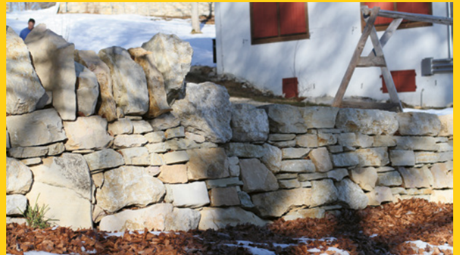
Gartenmauer / Mur de jardin
