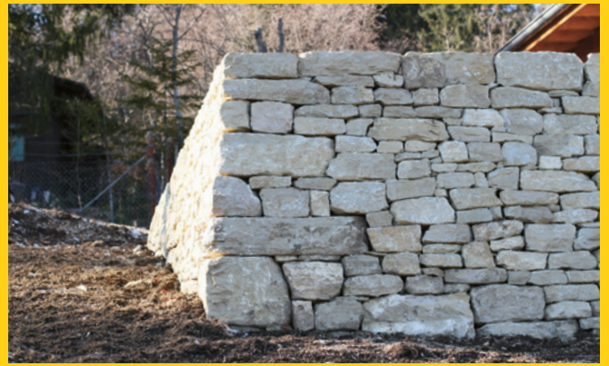
Terrassen-Stützmauer / Mur de soutènement de terrasse
